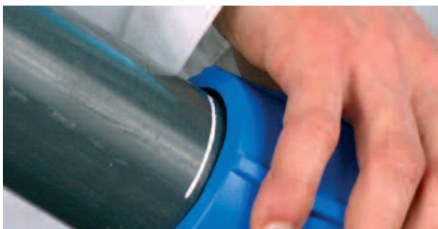
L'installation des raccords de la série MagnumMAX est, elle aussi, simple et rapide : laisser le tuyau entrer librement dans le raccord sans forcer, daucune façon.
