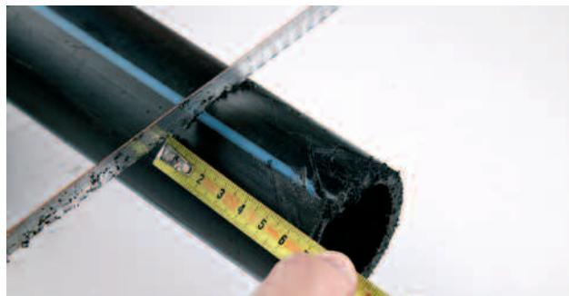
Les bavures et les copeaux doivent être enlevés, à l'intérieur et à l'extérieur, des extrémités du tuyau. Il est préférable d'utiliser un outil de biseautage, mais un couteau de poche ou une lime sont toutefois adaptés à l'opération. Pour les tuyaux jusqu'à 63 mm de diamètre l'exécution d'un petit biseautage sur l'extrémité facilite l'insertion du tuyau dans le raccord, mais l'opération n'est pas indispensable.
