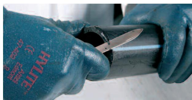
Per il collegamento di tubi oltre i 63 mm con raccordi MagnumMax, l'operazione di smussatura non è mai richiesta.
